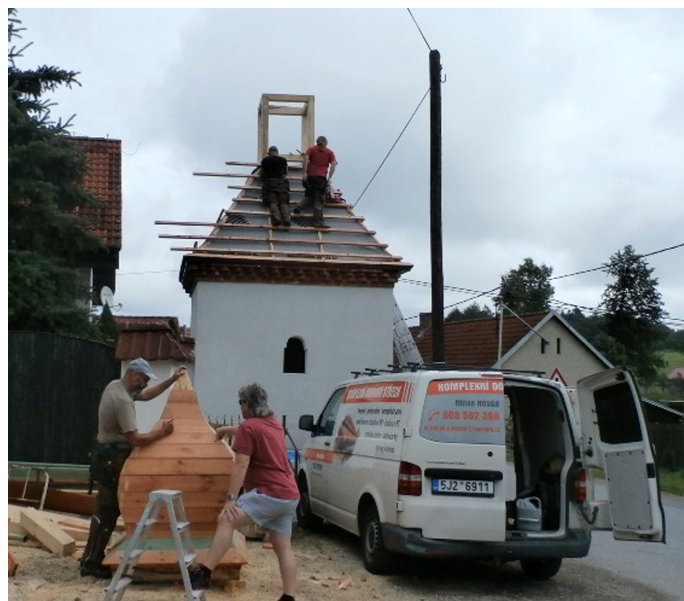
Kaplička během rekonstrukce
