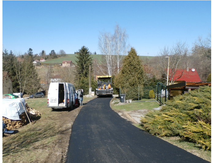
Oprava komunikace Lhota Veselka
