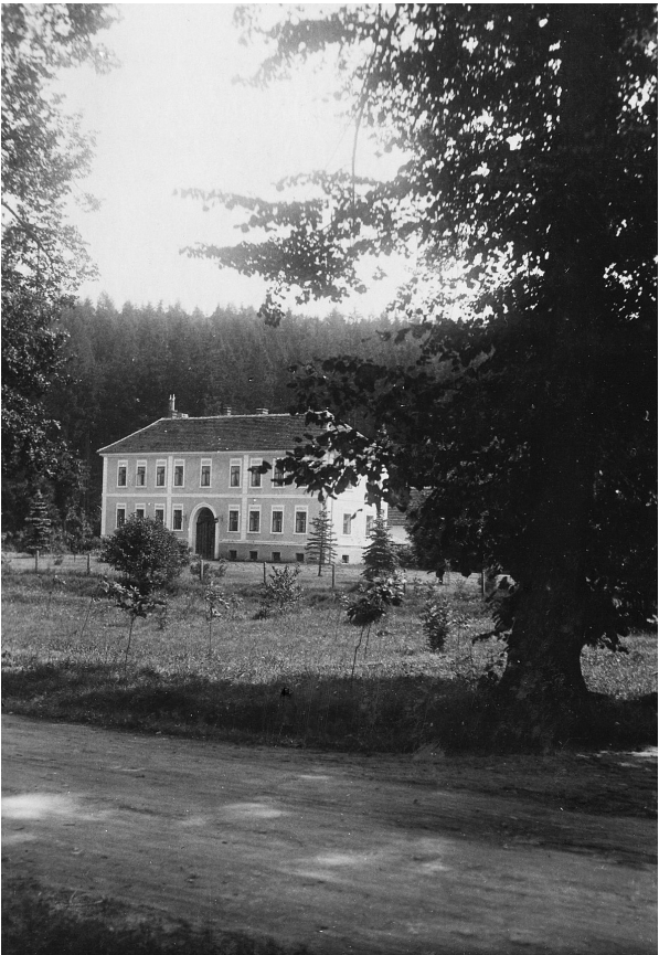
Tovární budova po přestavbě na zámek v roce 1928.
