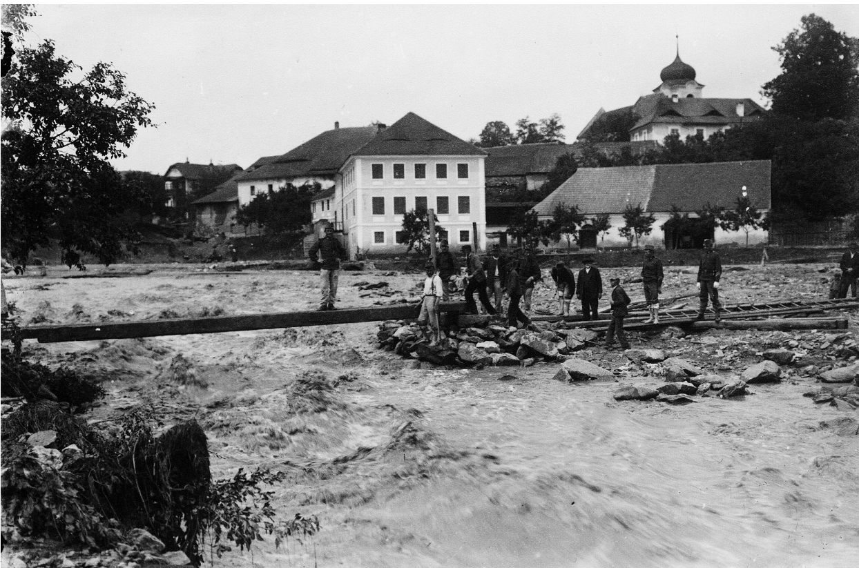
Stavba provizorního přemostění Chotýšanky.
