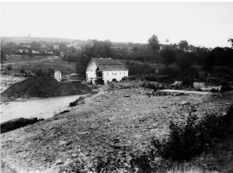
Protržená hráz Dolejšího rybníka s pobořeným Paurovým mlýnem, dnes pilou v Chalupách. (Muzeum Podblanicka Vlašim)
