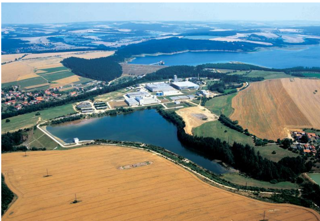
(c) Vodohospodářský rozvoj a výstavba a.s.
