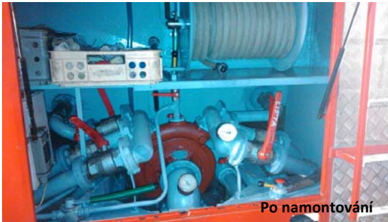
Před namontováním nového čerpadla
