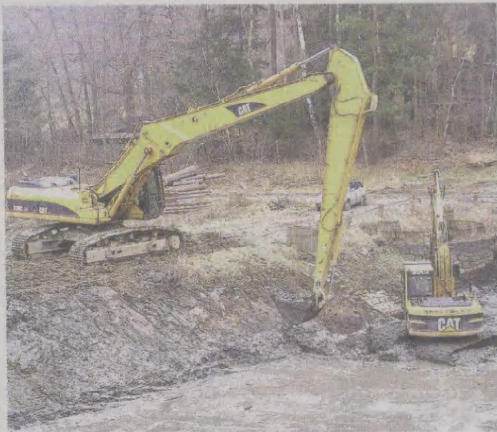
ODBAHŇENÍ. Mžížovický rybník se po rozsáhlé rekonstrukci stane opět místem k vodním radovánkám.
